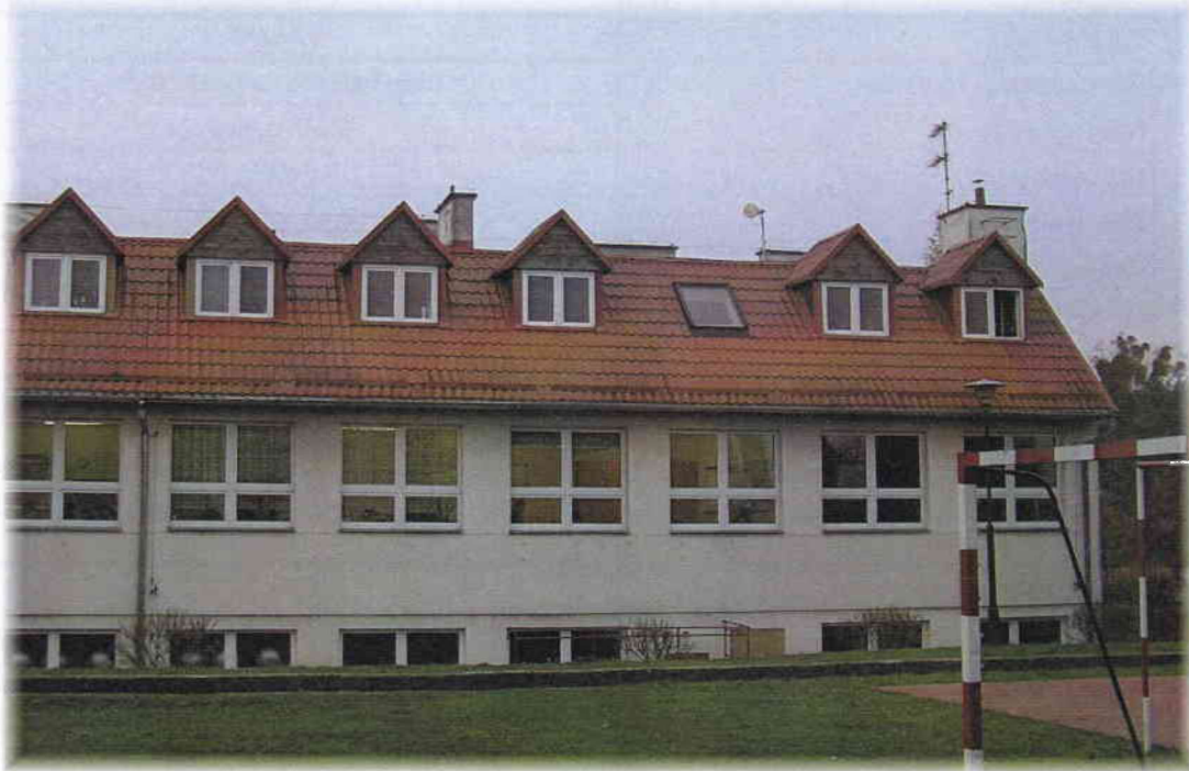
Fot. 1. OM Zawda 14 – widok budynku z anteną linii radiowej Emitel
