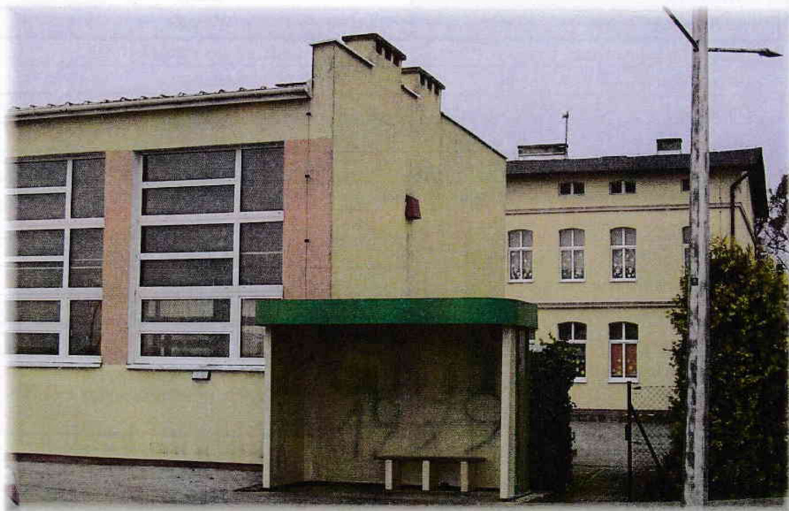
Fot. 1. OM Bursztynowo 44 – widok budynku z anteną linii radiowej Emitel
